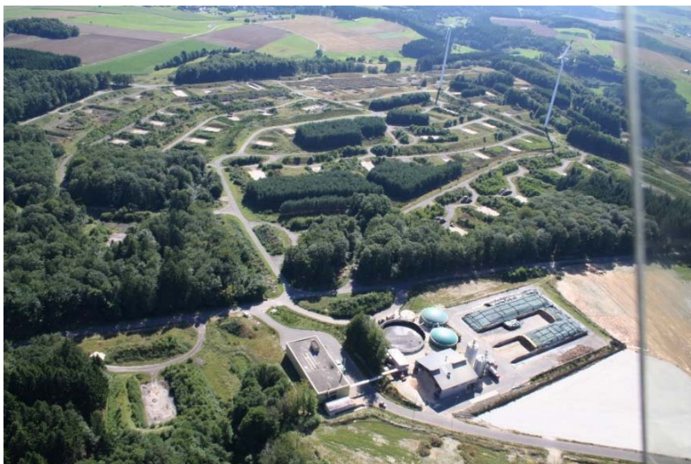
Abb. 13: Energielandschaft Morbach mit Biogasanlage und Pelletwerk (Foto: Gemeinde Morbach).
