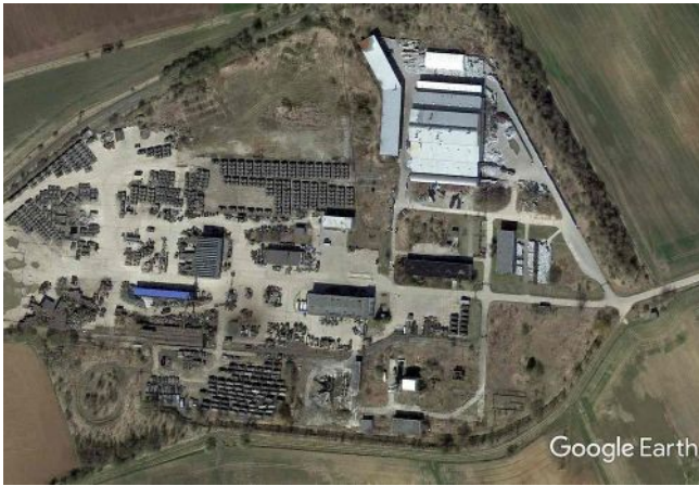
Abb. 3-5: Panzerverschrottungsanlage in Rockensußra
